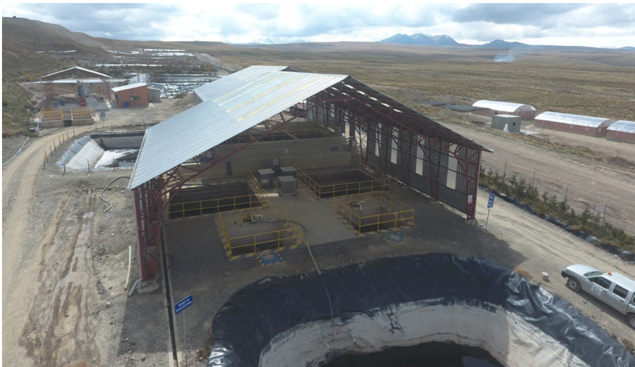
Galpones de tratamiento de lixiviados, relleno sanitario El Ingenio, El Alto.
