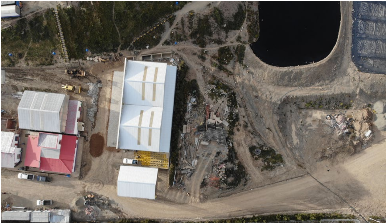
Toma aérea de las instalaciones del relleno sanitario El Ingenio, El Alto.
