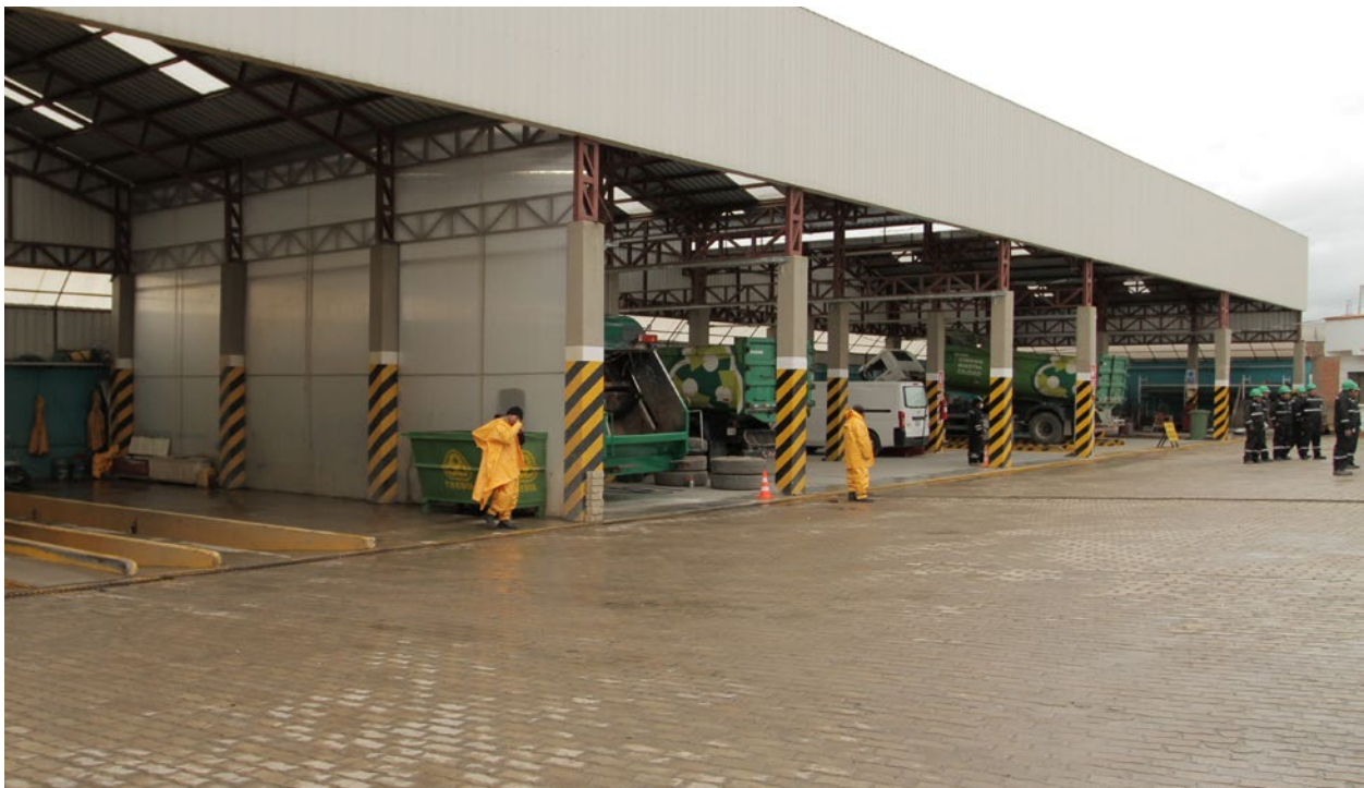
Base de Operaciones de la empresa TREBOL S.A., El Alto.
